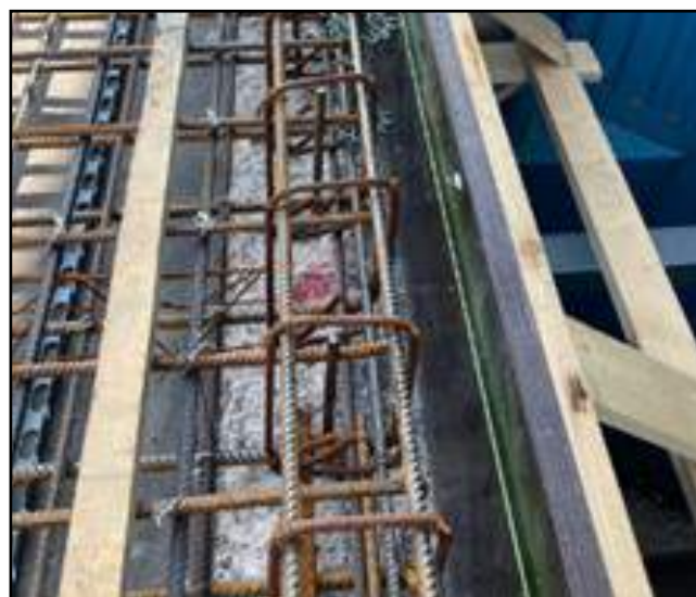
Armering klargjort til støbning
