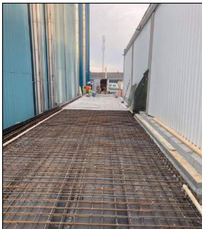
Armering klargjort til støbning
