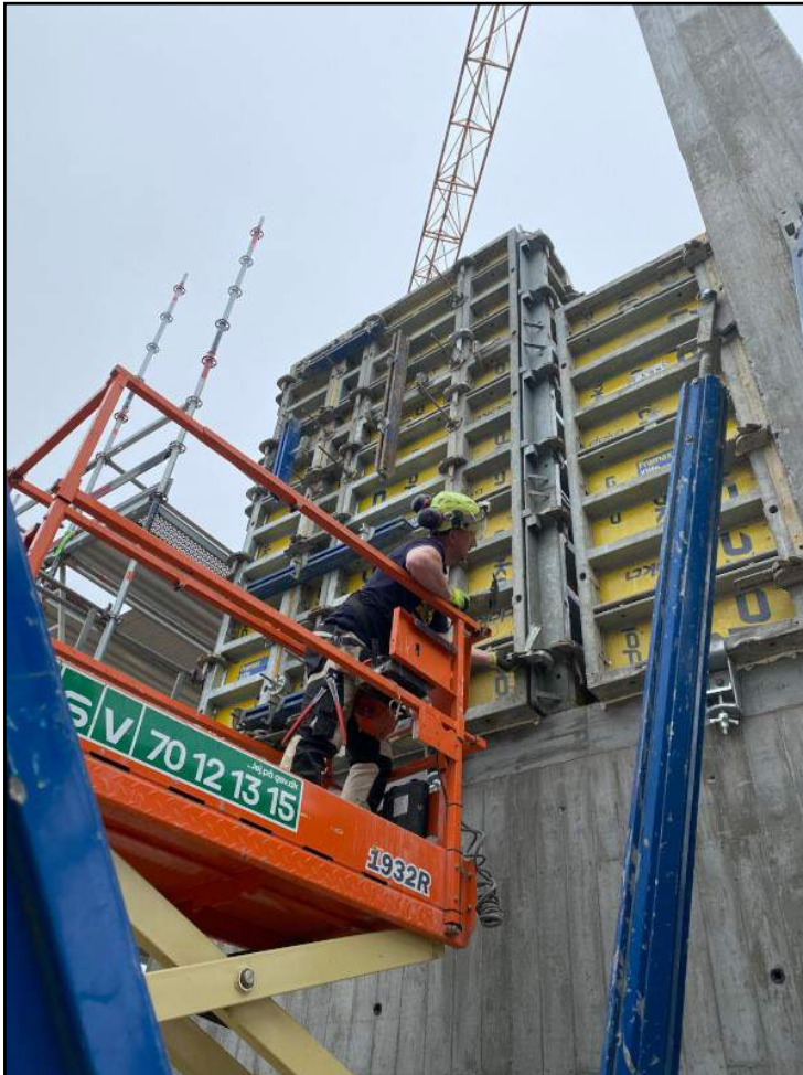
Kranføreren placerer, med nøje præcision, forskallingsformene, så de sidste vægge kan støbes
